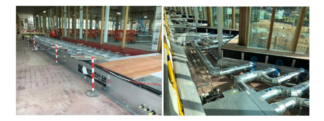
Roof Sprinkler Main Level 2 Allen av Level 1
